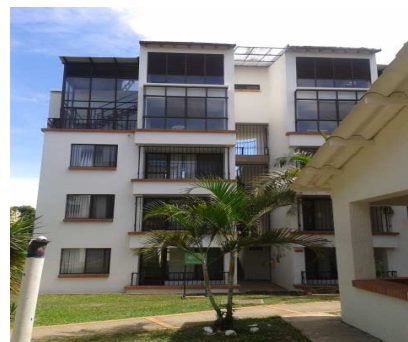
Torre de apartamentos
