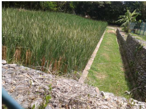
PTAR (Filtro de agua residuales)
