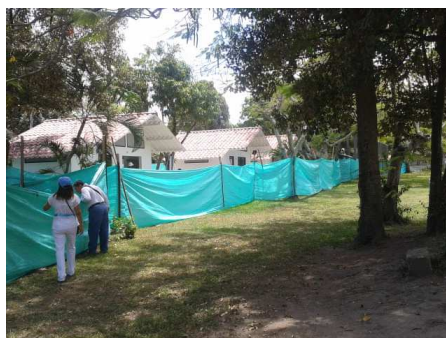
Cabañas en remodelación
